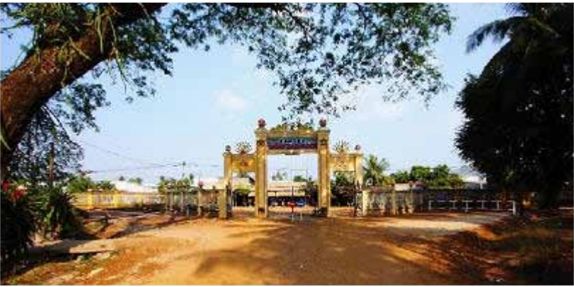
Cổng số 11, được xây năm Mậu Thân 1968
