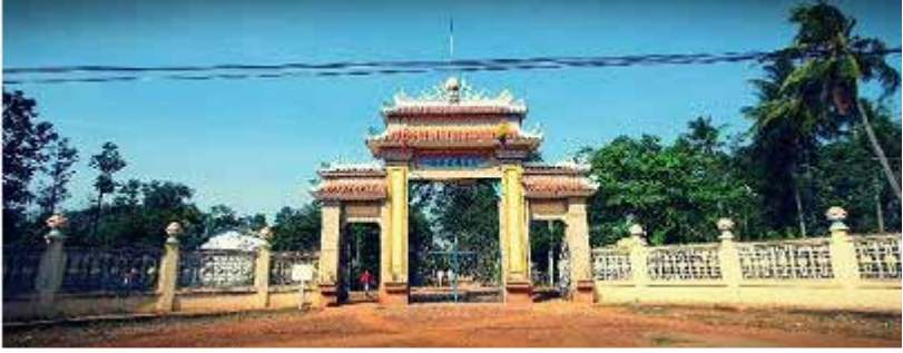
Cổng số 10, được xây năm Mậu Thân 1968
