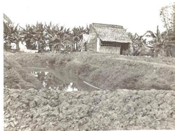
Đào mương thủy cấp và hạ phèn
