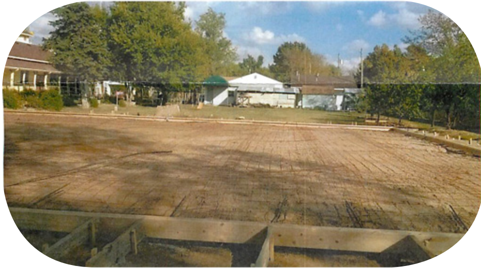
Nền móng Hội Trường chuẩn bị đổ bê tông 120 feet dài, 40 feet rộng
